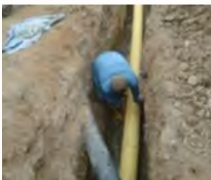
Instalación de tubería PVC con sistema de sellado hermético
