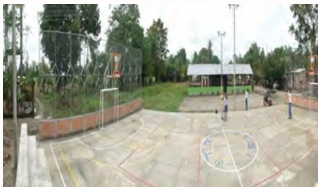
Construcción de cancha multifuncional Corregimiento La Llana, San Alberto, Cesar
