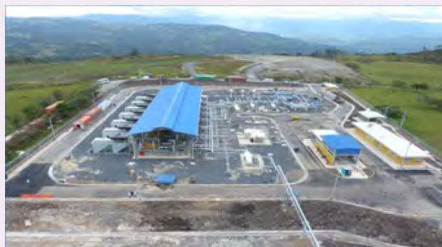
Panorámica Estación Puente Guillermo
