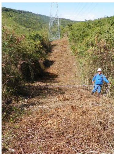
Foto 2 Medición en campo del ancho de las franjas de despeje en el Proyecto Tesalia – Altamira, 2014
