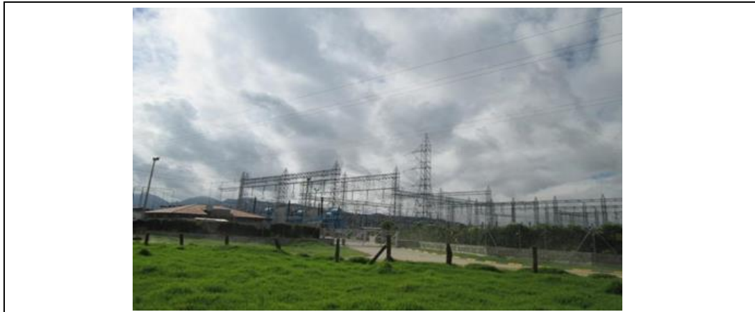
Fotografía 2-4 Vía de acceso Subestación Bacatá
