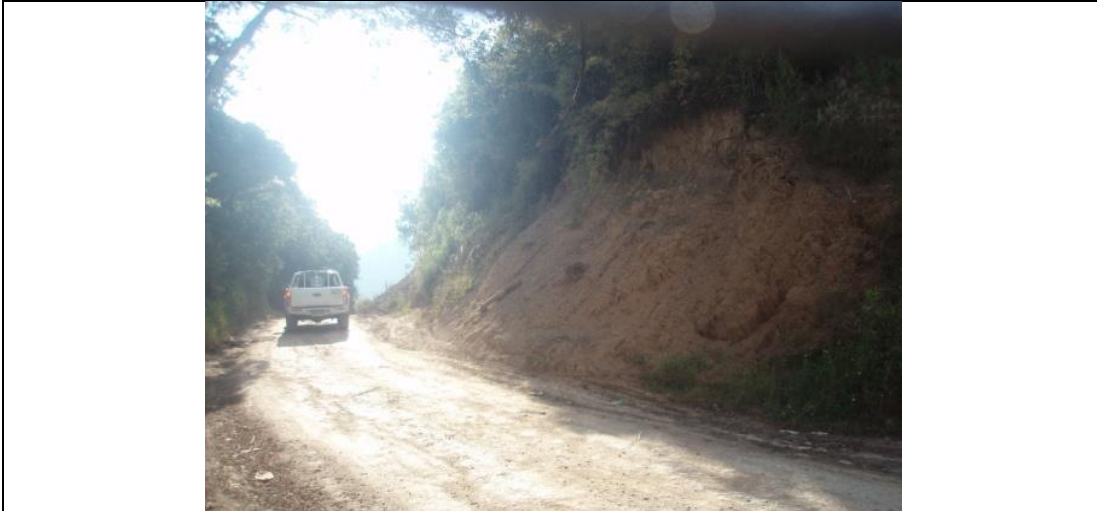
Fotografía 3-14 Remoción en Masa. Municipio de Macanal. Vereda Aguablanca.
