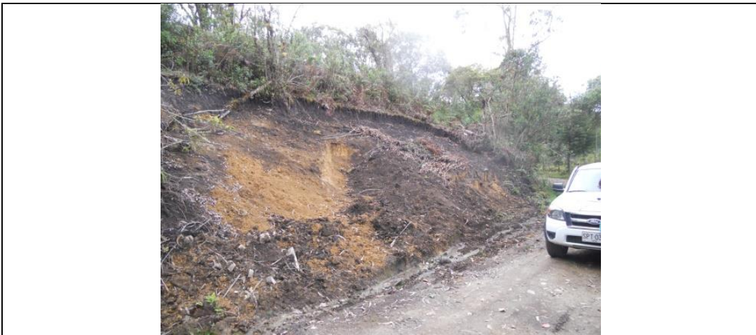
Fotografía 3-17 Remoción en Masa. Municipio de Macanal. Vereda Aguablanca
