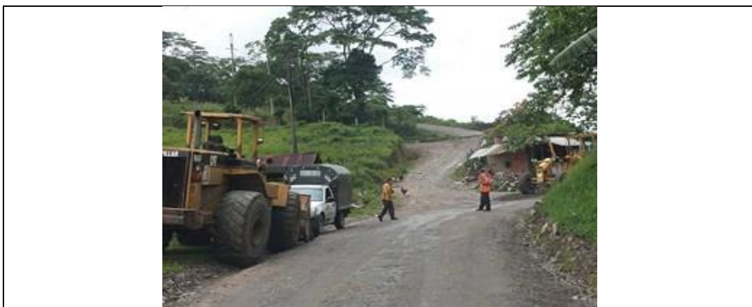
Fotografía 3-6 Frente de obra en la Vereda Arrayanes
