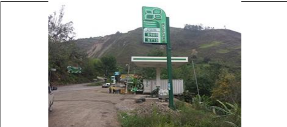
Fotografía 3-5: Estación de servicio Vereda Resguardo Bajo
