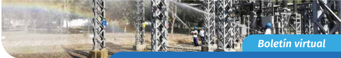
Lavado en caliente. Subestación Termocandelaria, Cartagena (Bolívar)
